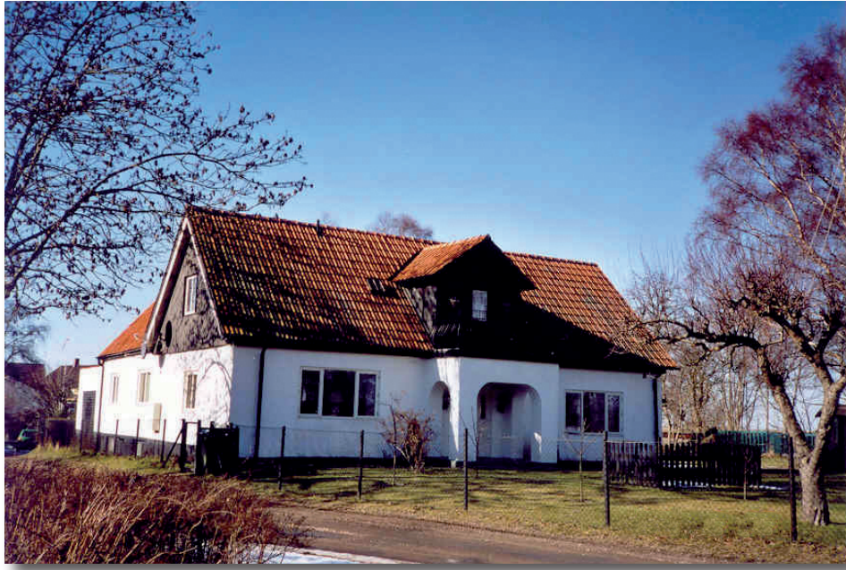
I detta hus låg tidigare handelsboden.
