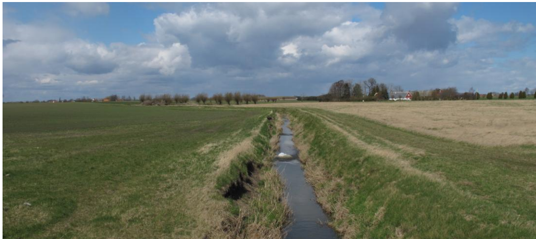
Figur 13 Gessiebäcken där ny bro/trumma kommer att anläggas
